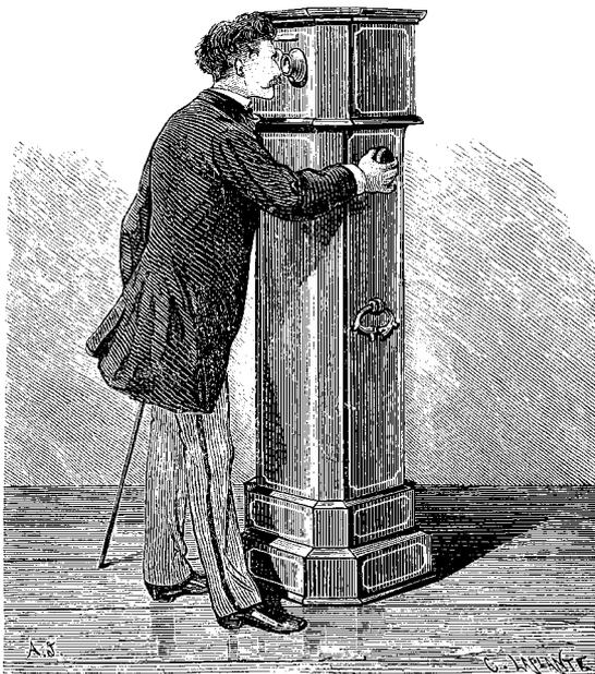
*Abb. 18: Säulenstereoskop, um 1860. Die in einem Magazin befindlichen Stereobildkarten werden durch einen speziellen Mechanismus transportiert*
