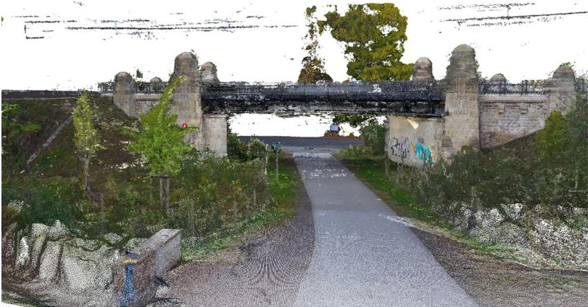
Abb. 6: Photogrammetrische Punktwolke einer Eisenbahnbrücke basierend auf Handaufnahmen und UAV-basierten Aufnahmen
