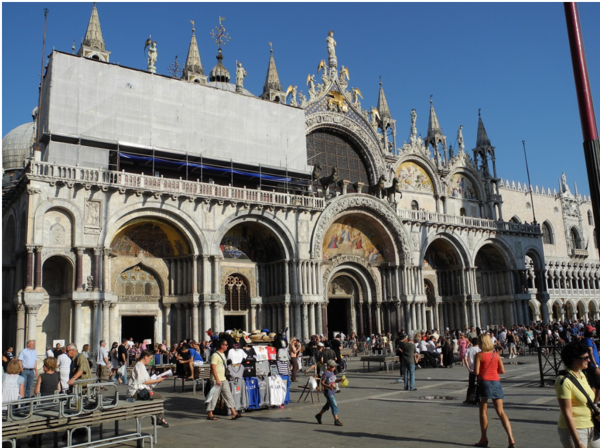
Abb. 1: Venedig Markusplatz mit gestapelten Hochwasser-Bänken (Foto Y. Schleicher)
