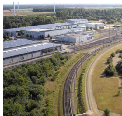
Das Gelände von RailGATE in der Nähe von Aachen (Foto: Cenalo/Logiball).
